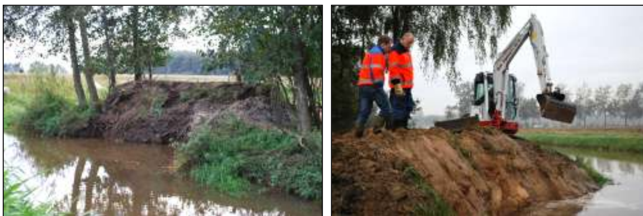
Aanleg IJsvogelbroedplaatsen langs de Leijgraaf
